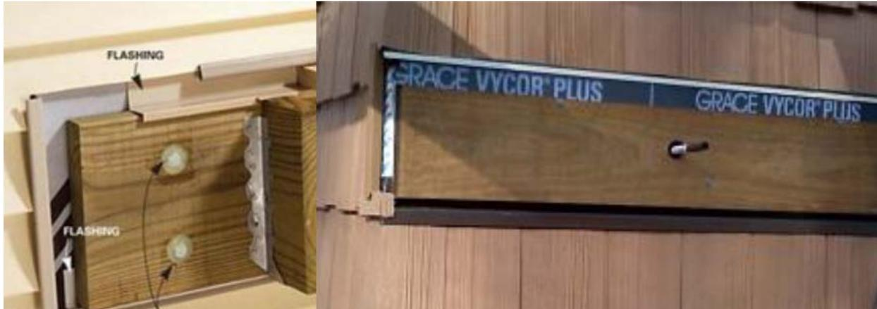
Tablas de borde deben estar conectadas a la estructura por tornillos tirafondos o pernos que son galvanizados en caliente o acero inoxidable.
