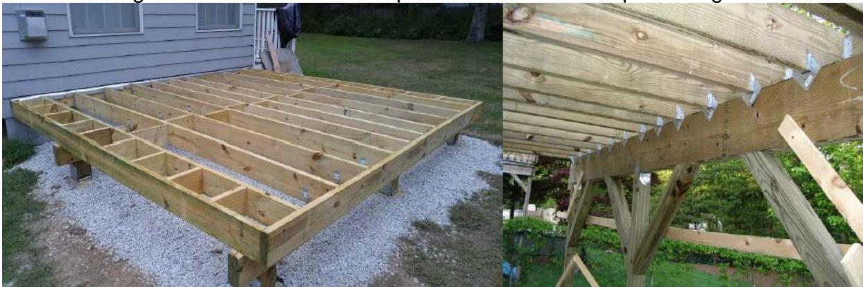
Entramado de cubiertas pueden ser soportados por soporte de vigueta conectados a las vigas.
