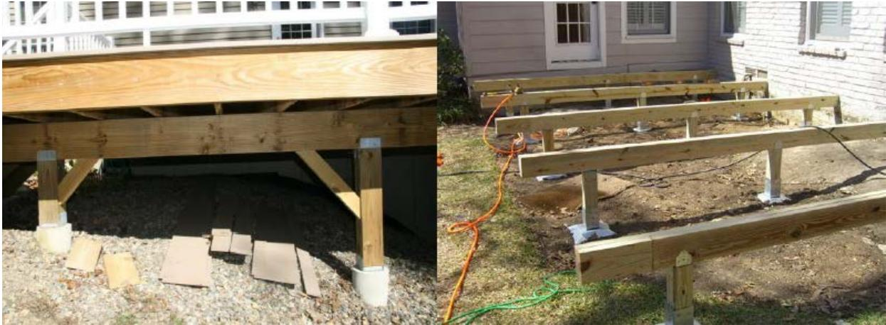
Vigas de cubiertas deben estar directamente sobre los postes o zapatas
