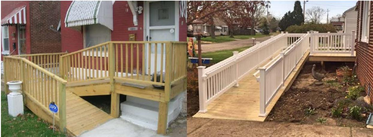
Se requiere barandales en al menos un lado de cualquier rampa que exceda 1 unidad vertical en 12 unidades horizontales. Los barandales de las rampas deben cumplir las mismas pautas que los barandales de las escaleras (34-38 pulgadas de altura y que sean agarrables). Separación entre balaustres no debe exceder las 4 pulgadas. Los barandales donde se requiera en las rampas, deberán ser continuos para toda la longitud de la rampa.
